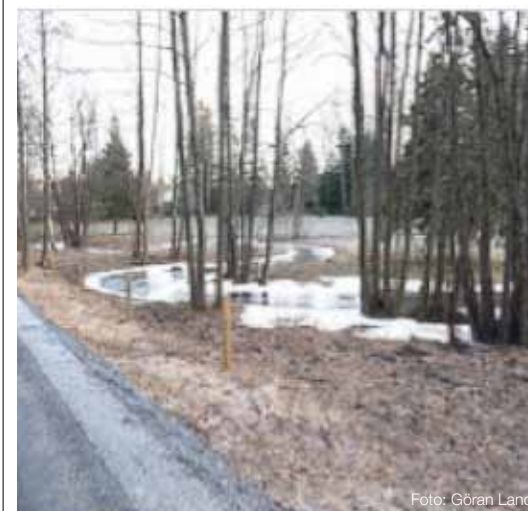
Åtgärder för att fördröja vattenflöde i Fullerstaån
